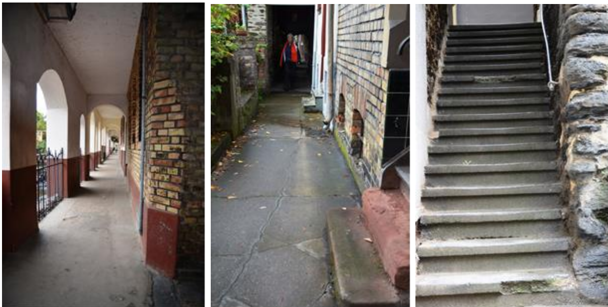
Abb. 38 Umfangreiche Schäden am Arkadenweg über die Stadtmauer und den Zugängen
